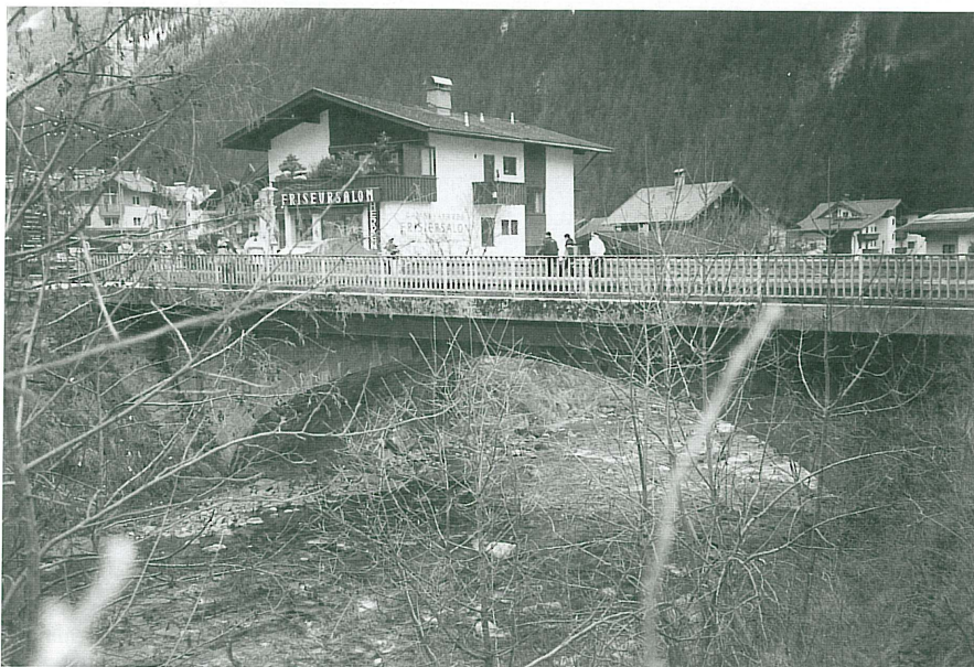
Abb. 4: Die Hollenzbrücke über dem Ziller (früher Hollenze ) in Mayrhofen. Auf der orografisch linken Seite dieser Brücke befand sich einst der Weiler Hollenzbruck .
