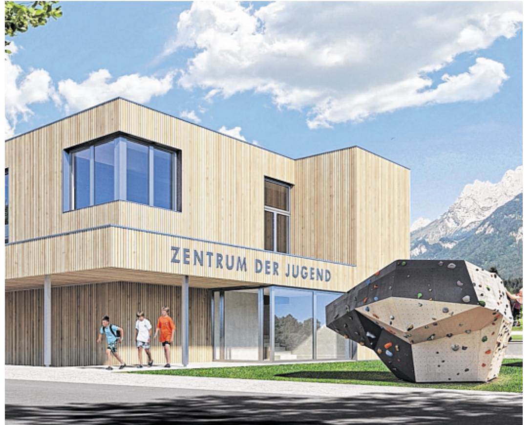
Im Erdgeschoß ist das Jugendzentrum geplant, im 1. Stock die Boulderhalle.
