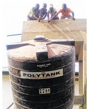
Bauarbeiter bei der Installation des 1000-Liter-Polytanks.
