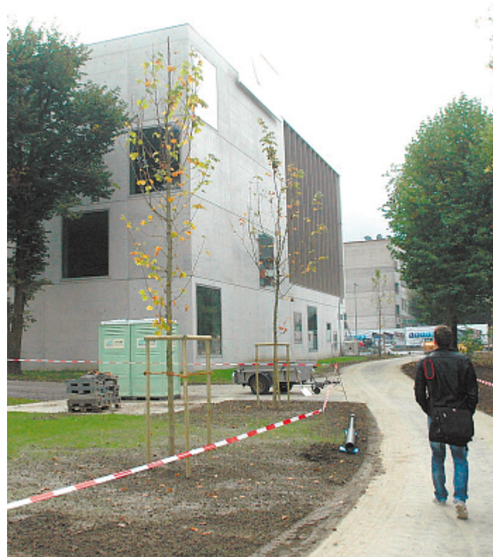
Die dritte Baustufe der Kufsteiner FH ist bezugsbereit. Foto: Otter
