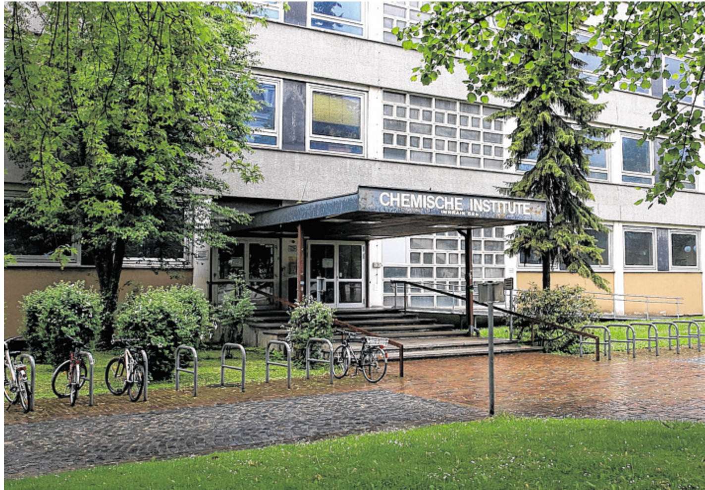
Die „Alte Chemie“ der Uni Innsbruck bleibt nach dem Strahlenunfall weiter geschlossen. Noch ist unklar, was mit dem Gebäude passiert. Foto: Hettfleisch J.
