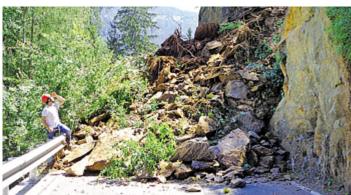
Die Straße wurde bereits gestern größtenteils geräumt, die Verkehrsfreigabe erfordert noch die Besichtigung durch den Geologen. Foto: Baubezirksamt Lienz
