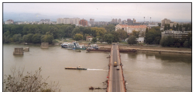
Novi Sad: Behelfsbrücke über die Donau (Im Bild links die Reste der zerstörten Brücke).
