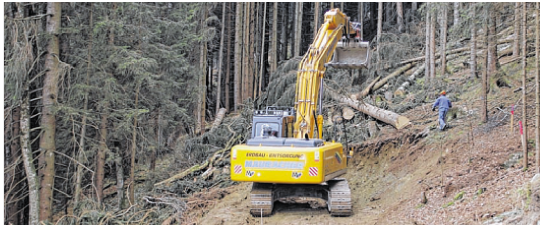
Der Bagger gräbt sich bereits Richtung Pletzerhof, bis Herbst 2013 soll die Straße fertig gestellt sein. Foto: Angerer
