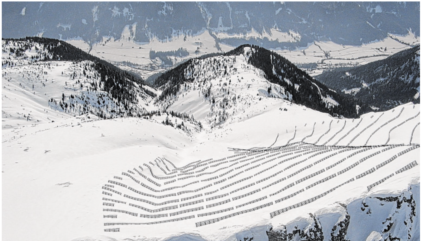
Nicht alle Lawenstriche können wie hier im Gschnitztal oberhalb von Trins mit technischen Mitteln verbaut werden.
