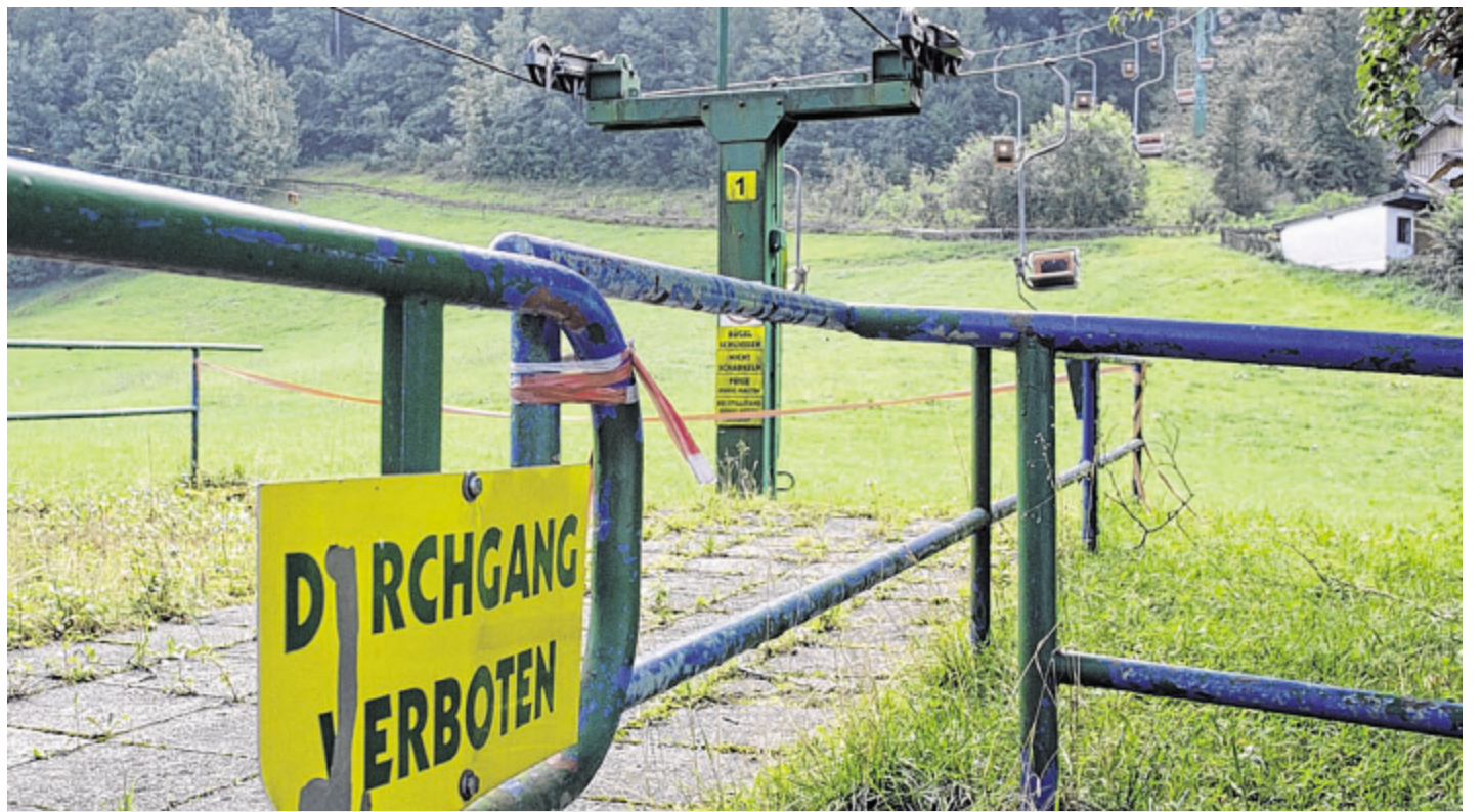
Im Herbst 2010 haben die Sessel des Kufsteiner Kaiserlifts zum vorerst letzten Mal Fahrgäste auf den Berg befördert. Foto: Mader
