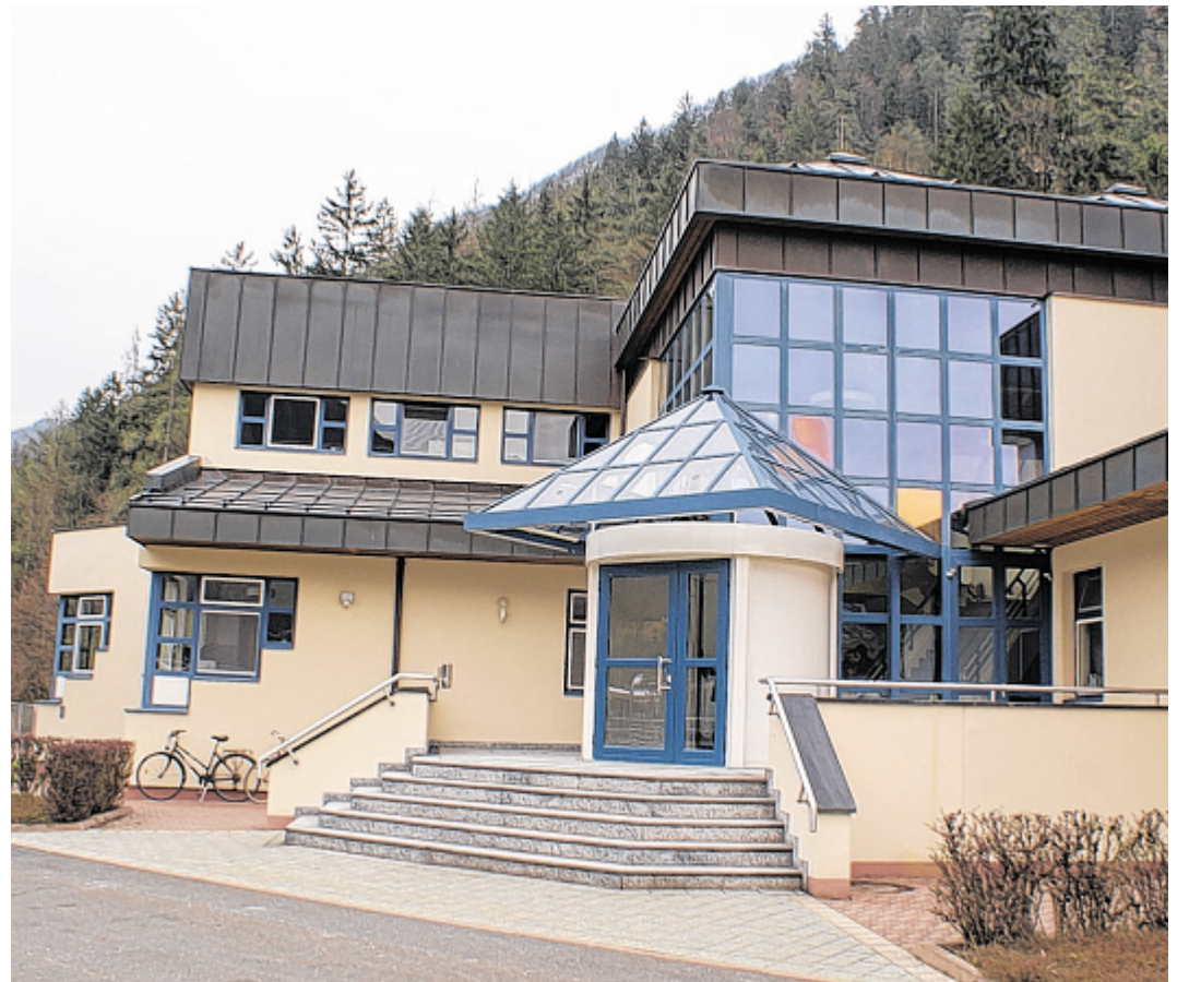
Die Kläranlage bei der Großsache-Nord in Kirchdorf wird weiter ausgebaut. Es entsteht eine Aufbereitungsanlage für die Bioabfälle von Hotels. Foto: Hofer
