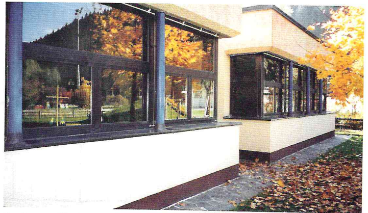
Sanierung Kindergarten West
