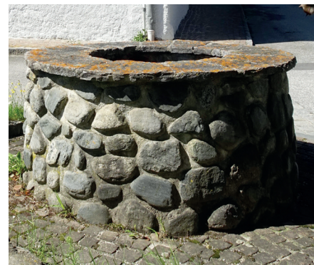
Der Tiefbrunnen in Unterperfuss (außer Betrieb) weist darauf hin, wie das Wasser aus der Tiefe des Inn-Grundwasserstandes heraufbefördert wurde. So wird es im Unterdorf von Völs passiert sein. Die Brunnen waren überdacht und mit einer Winde zum Hochziehen der Eimer versehen.
