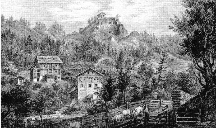
Das vordere Gebäude zeigt die Mühle in Betrieb, mit dem Wasserradschuppen an der linken Seite, mit dem oben über den „Schuss“ zugeleitetem Wasser, das nach dem Antrieb des Rades unten aus dem Schuppen herausschießt. Bild: Burgruine Vellenberg mit dem Weiler Bauhof von Caspar Großrubatscher, 1830. Tiroler Landesmuseum Ferdinandeum.
