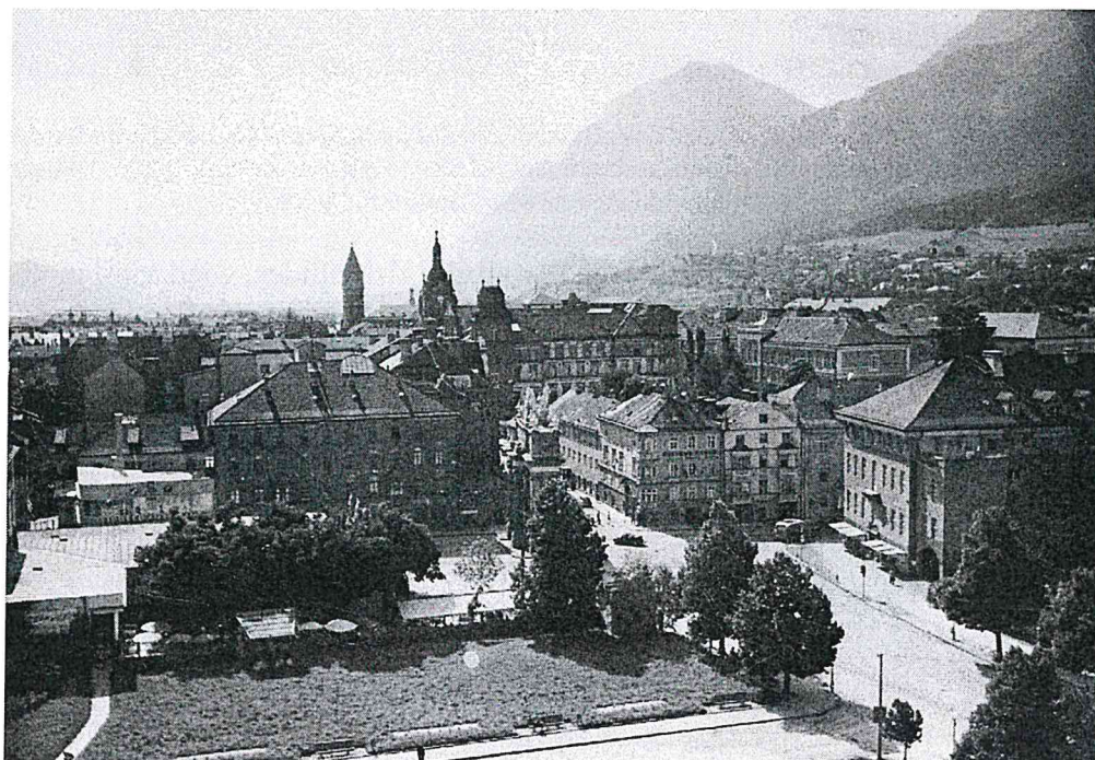
Abb. 5 Blick vom „Hochhaus Richtung Triumphpforte“ „Greifgarten“ Einsatzort der Feuerwehr Zirl am 16.12.1944. Bild: Original Stadtarchiv/Stadtmuseum Innsbruck
