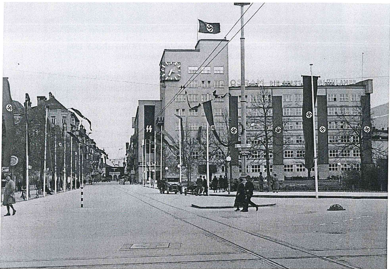
Abb. 4 Hochhaus mit dem im Vordergrund liegenden „Bismarkplatz“ (heute Casino), geschmückt für den Besuch Adolf Hitlers am 5. April 1938. Bild: Original Stadtarchiv/Stadtmuseum Innsbruck
