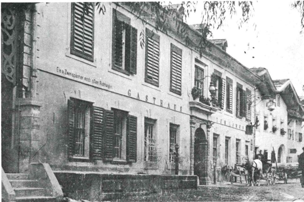
Gasthaus zum Löwen und nördlich angebaute Häuser vor dem Brande
