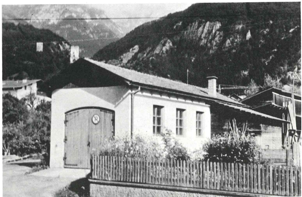
Zusätzliches Gerätehaus beim Altersheim von 1953 - 1970
