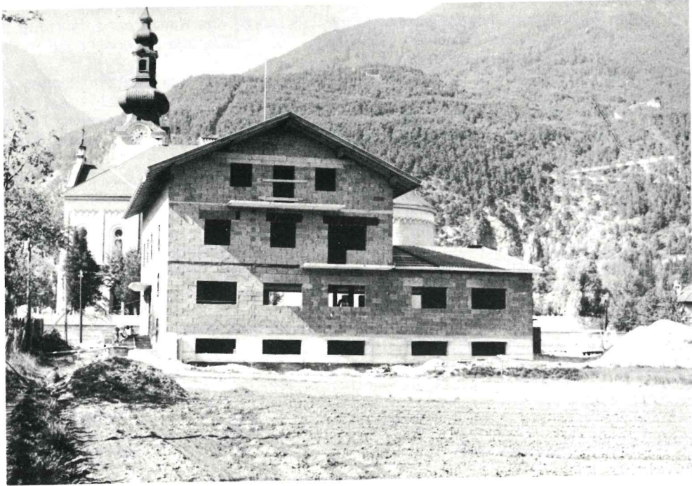
Neues Gerätehaus im Rohbau - 1968
