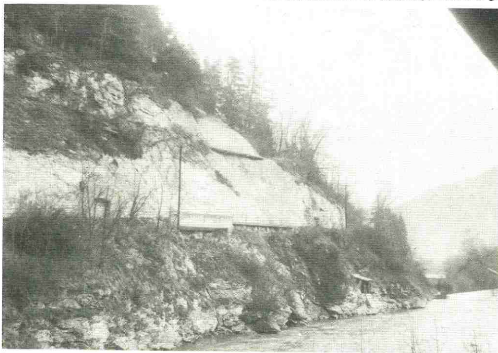
Der sanierte Perjenerweg
