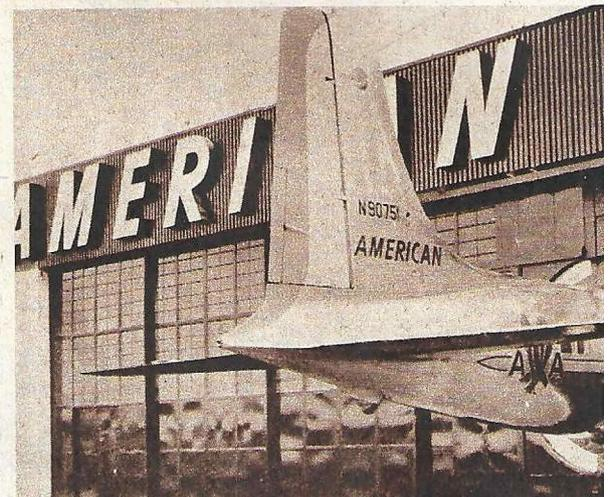
**WIE EINER GIGANTISCHE JAGDTROPHÄE** ragt das Heck einer DC-6B aus der Stirnwand des neuen Hangars der „American Airlines“ auf dem internationalen Flughafen in San Francisco. Die mächtigen Tore, die den Rumpf des Flugzeuges eng umschließen, erleichtern den Mechanikern die Instandhaltungsarbeiten.
