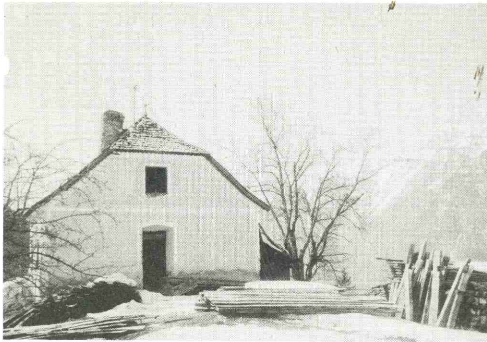
Das alte Schulhaus von Grist besticht durch die Harmonie der Dimensionierung seines Baukörpers.
