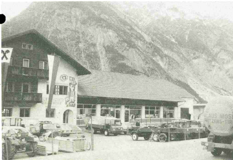
Das „Haus der Landtechnik“ mit Verkaufsraum und Ersatzteillager von außen. Es wurde am Freitag, 28.3.1980, eröffnet. Fotos Perktold
