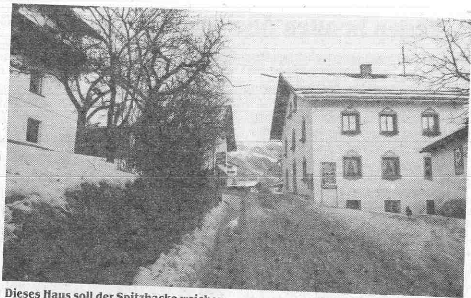
Dieses Haus soll der Spitzhacke weichen
