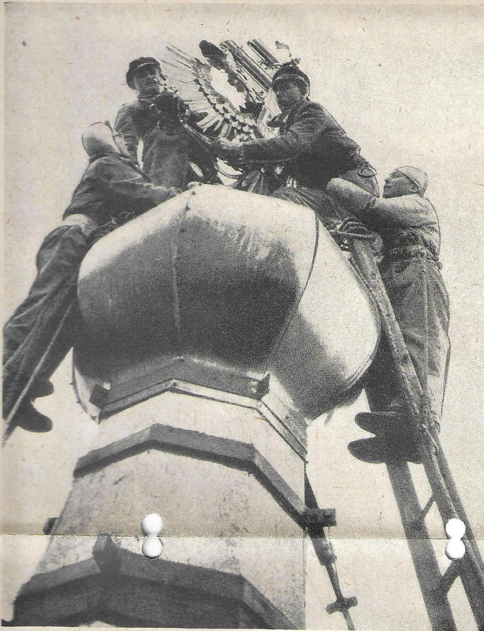
137 Meter über dem Erdboden, auf der Spitze des Stephansturmes, haben Meister und Gesellen der Kirchturm-Instandsetzungsgesellschaft ihre Werkstätte aufgeschlagen, um den Adler, der nur schwer abmontiert werden kann, zu überholen.
