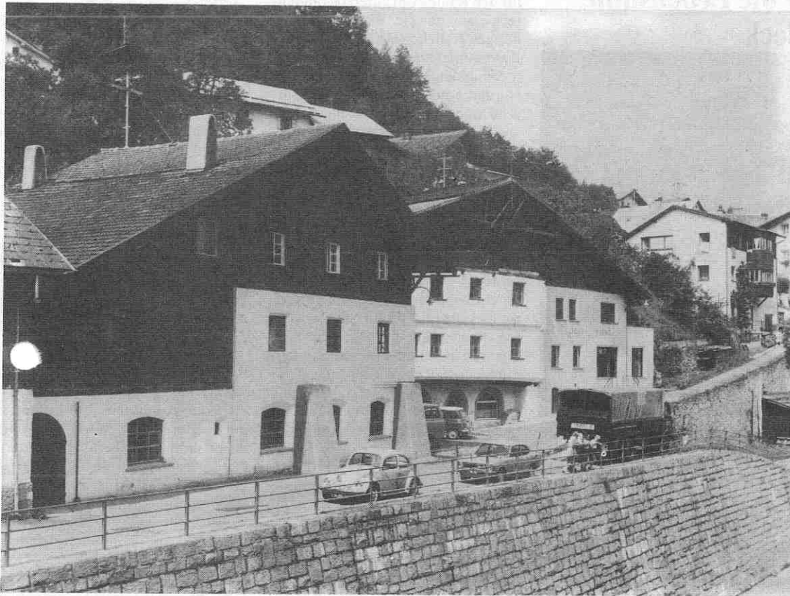
Der historische Teil des Gerberhauses rechts, der Anbau aus neuerer Zeit links
