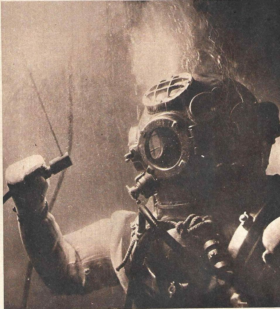
**In zwanzig Meter Tiefe** arbeitet hier ein Taucherlehrling mit einem Schneidbrenner an einem Übungsobjekt. Das Arbeitsfeld wird dabei durch zwei starke Unterwasser-Scheinwerfer erhellt.
