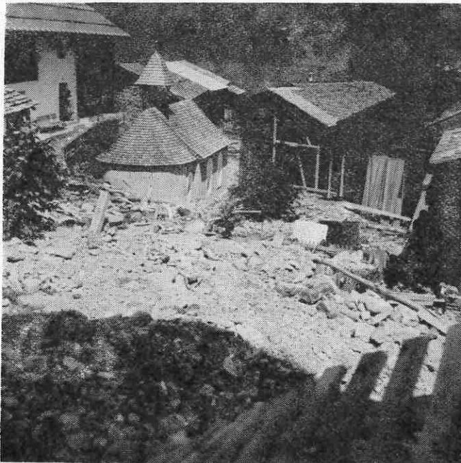
Mureinbruch in den Ort Habigen beim Hochwasser v. 25. Juli 1969.
