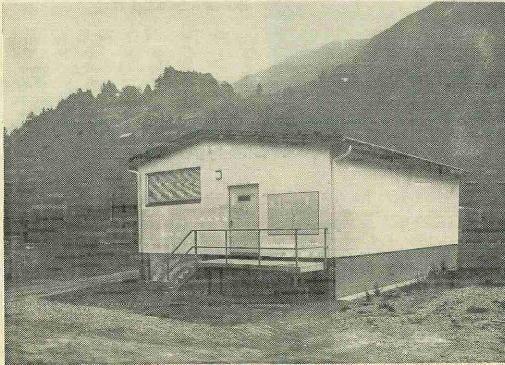
Ansicht der von der Tiwag neu in Betrieb genommenen 25/6 kV-Kuppelstation „Urtl“ in Landeck. (Tiwag-Werksfoto)
