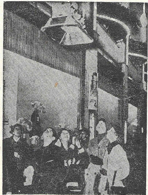
Strassen mit Warmluftheizung gibt es seit kurzem in Bremen. Die Heizkörper werden durch Leuchtgas aus dem städtischen Leitungsnetz gespeist. (AND)
