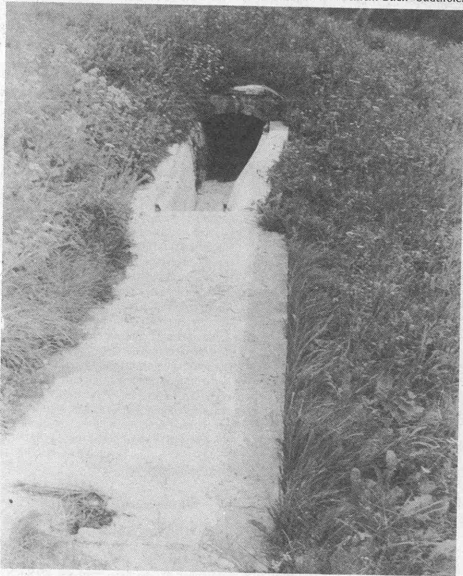
Ein Stück der Kaunerberger Bewässerungsanlage, die nach dem Weltkrieg erbaut wurde.
