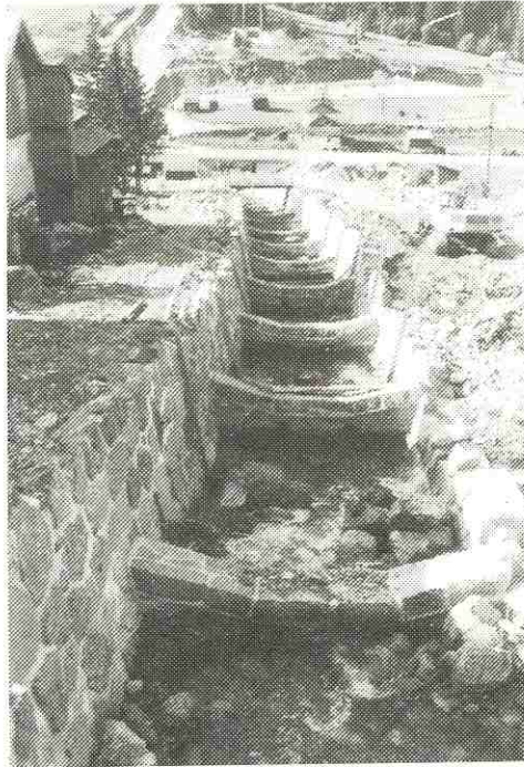
Die Verbauung des Schnanner Baches unterhalb der Dorfbrücke ist fast abgeschlossen
