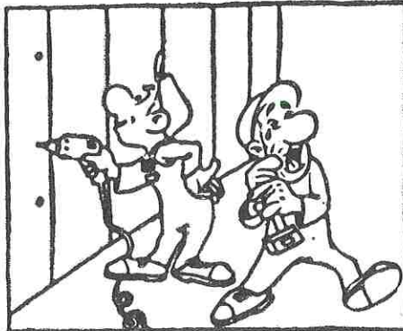
KNAUF-Bauplatten lassen sich ideal auf Holz- oder Metallunterkonstruktionen nageln und schrauben. Mit dem KNAUF-Schraubvorsatz wird jede Bohrmaschine zum Schnellbauschrauber.
