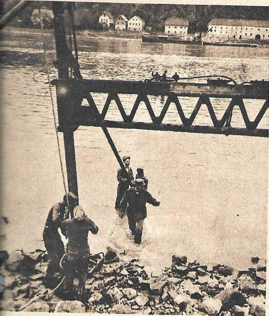
EINE NEUE ANLEGESTELLE für die Aschacher Rollfähre an Stelle der vom Hochwasser zerstörten bauen USFA-Pioniere, die auch das gesunkene Mittelstück der Fähre heben.
