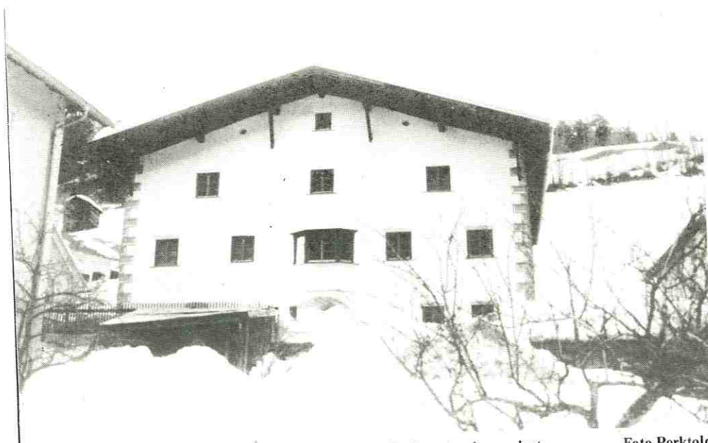
In Strengen wurde wieder ein altes Haus mit Liebe und Sachverstand renoviert.
