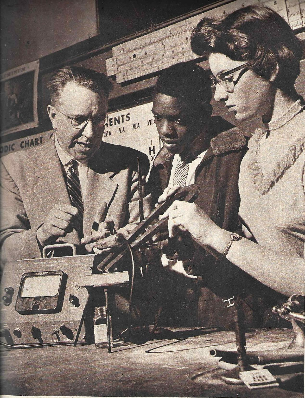
**Kleine Atomlaboratorien** wurden in den Physiksälen vieler Schulen in den USA eingerichtet. Hier beweist der Lehrer seinen Schülern mit Hilfe eines Geigerzählers die Ablenkung der von einer radioaktiven Substanz (im Fläschchen) ausgesandten Alpha- und Betastrahlen in einem Magnetfeld.
