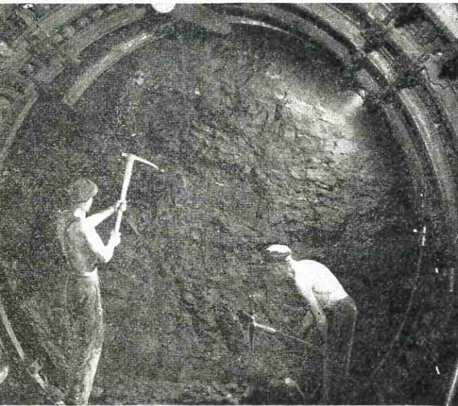
Innen der neuen Förderanlage und der alten Schachtanlage eine Verbindungsstrecke im Stahlstreckenausbau mit Zelt-Profilm angelegt (oben). An weniger druckhaften Stellen des Gebäudes erfolgt die Zimmerung im Holzausbau (rechts).
