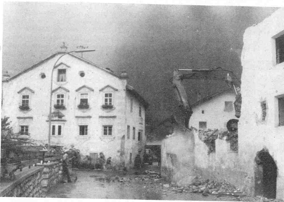
Der Abbruch des alten Patscheider-Hauses
