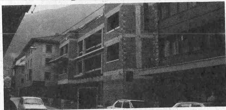
Der Bau bei der Firstfeier, Mitte November.
