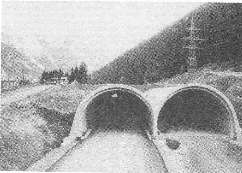
Der Pettneuer Tunnel als Unterführung des Malfonbaches
