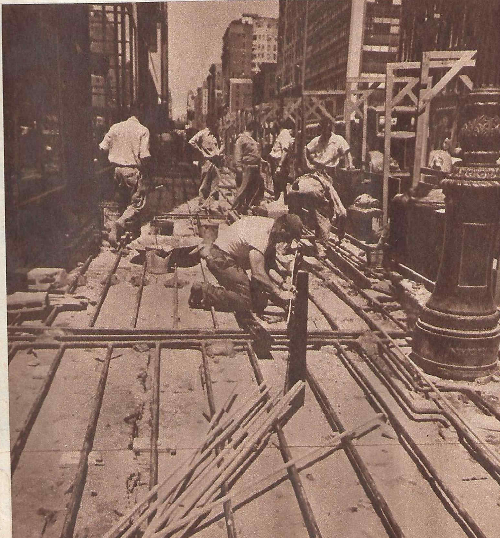
▲ Wieder am Cello findet man den spanischen Virtuosen Pablo Casals, der im April einen Herzanfall erlitt. Schnee- und eisfrei wird der Gehsteig um das Gebäude der C.I.T. Financial Corp. in New York das ganze Jahr hindurch sein. Das Rohrnetz für die Ölheizung wird bereits verlegt.
