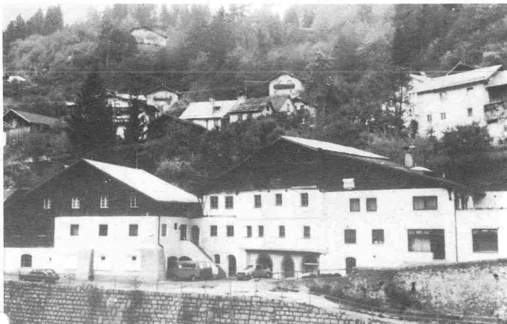
Das unter Denkmalschutz stehende Gerberhaus in Landeck wird von einem Rutschhang bedroht.
