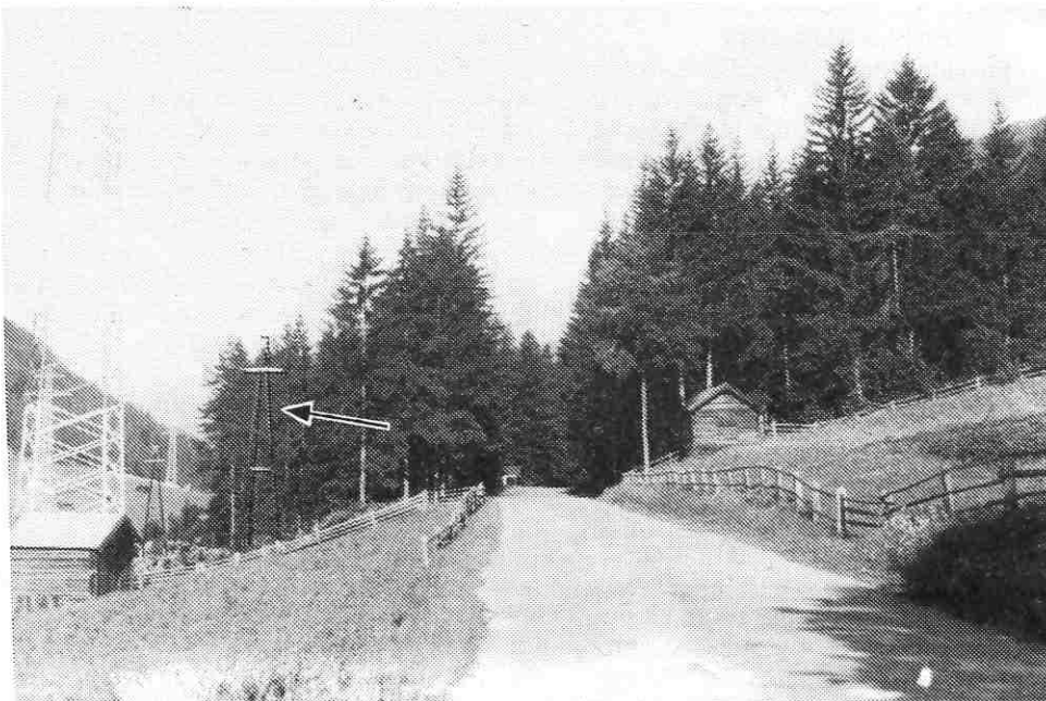
Die TIWAG-Leitung (Pfeil) wurde nun doch entlang der Schnellstraßentrasse und nicht in einer neuen Schneise durch den Wald geführt.
