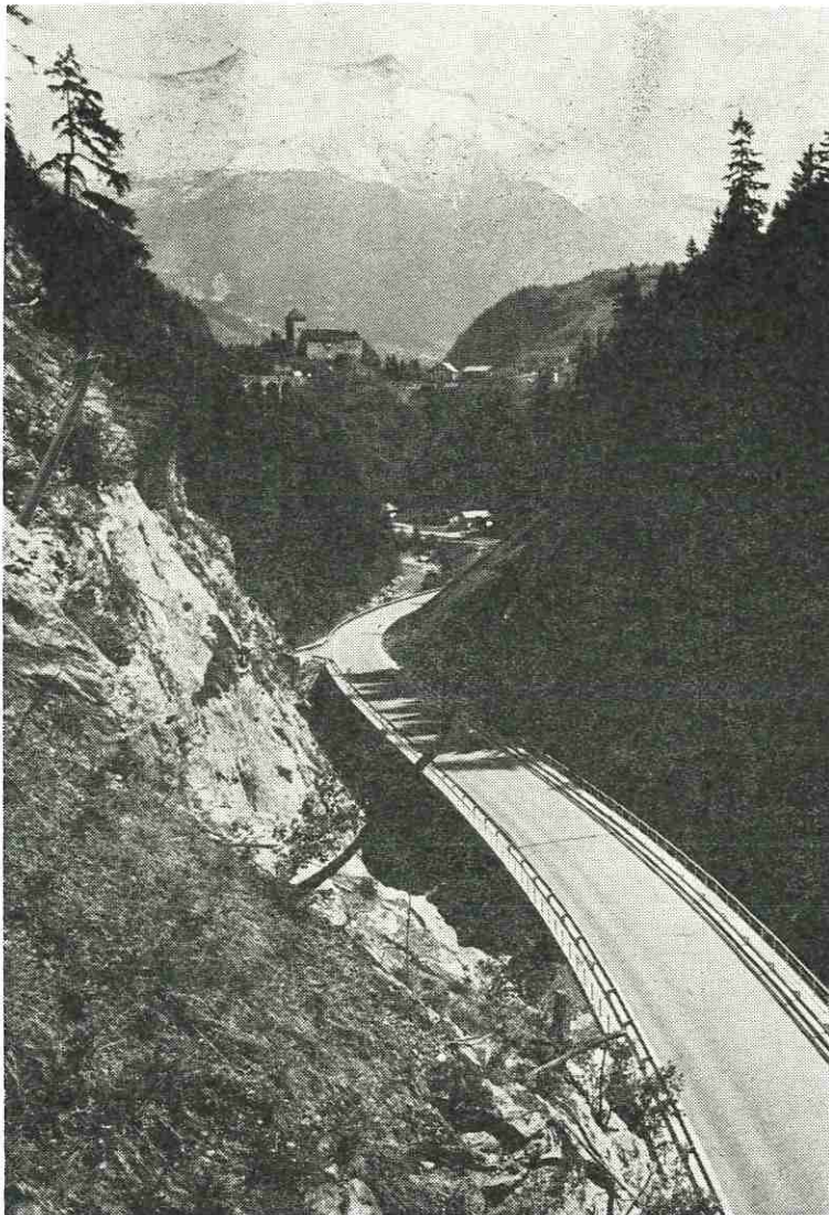
Paznauntalstraße - Baulos Wiesberg
