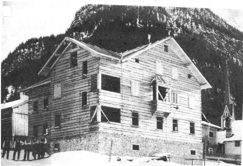
Erst im Jahre 1912 errichteten die Ischgl-Gemeindehaus. Links im vorliegenden Foto sehen wir die am Rohbau beteiligten Zimmerleute aus Langsthai.
