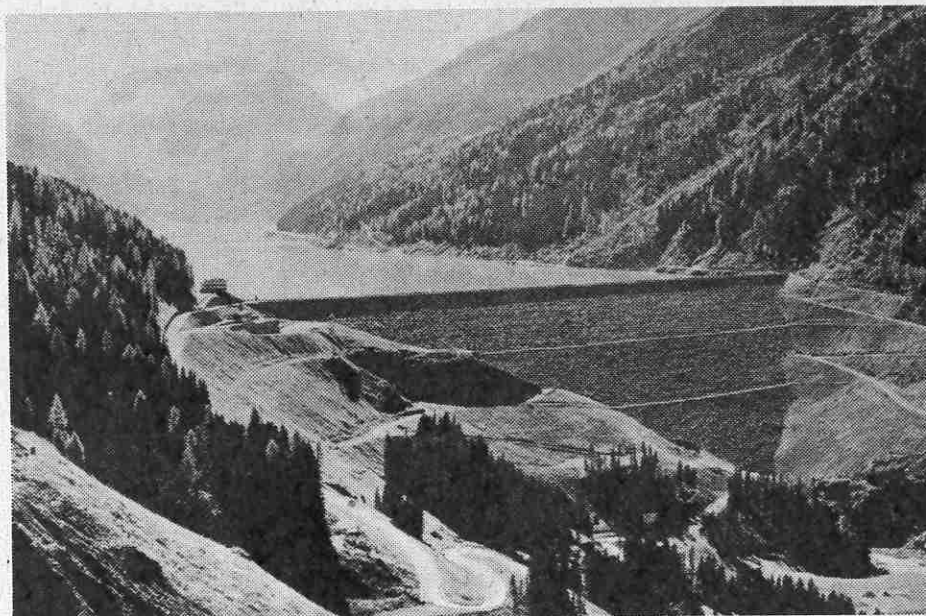
Der Staudamm und Speicher bei Vollstau.
