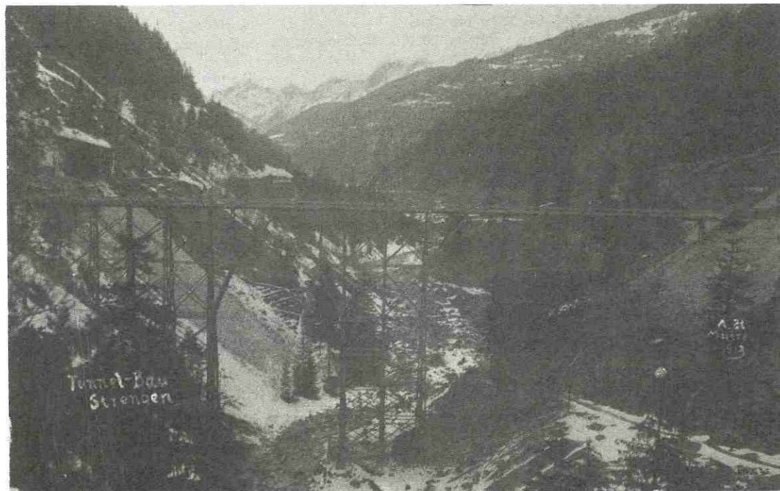
Für den Bau des Bahntunnels zwischen Wiesberg und Strengen mußte über die Rosanna eine Holzbrücke geschlagen werden. Das Bild wurde uns von Johanna Bernhard aus Pians zur Verfügung gestellt.
