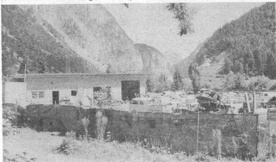
Die ungenehmigte Lagerhalle in Zams/Fineis.
