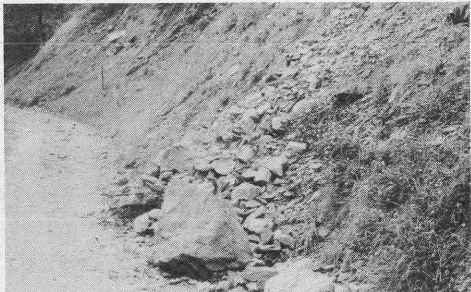
Teilstück des neuen »Wanderweges« zwischen Grins und Strengen.
