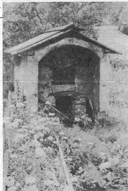
Muß dieser Backofen der Straßenverbreiterung weichen? Fotos: Perktold
