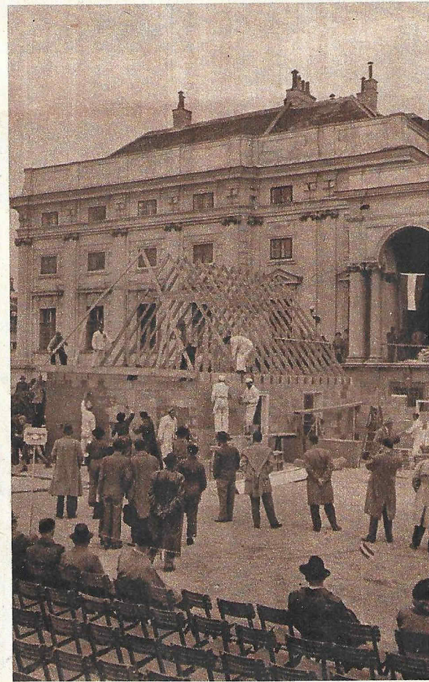
Um 7 Uhr begonnen, um 12 Uhr unter Dach um 19 Uhr bezugsfertig war das Haus, das aus zierten Teilen nach einem neuen Verfahren auf dem Schwarzenbergplatz zu Demonstrationszwecken gebaut
