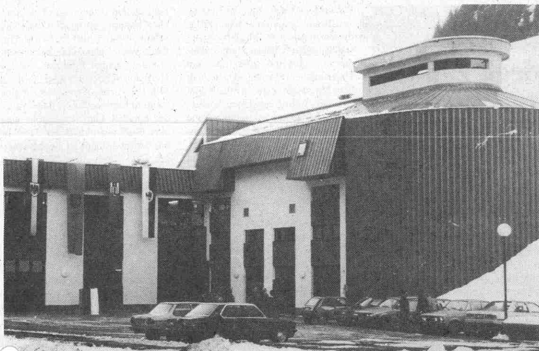
Das Klärwerk Oberpaznaun wurde vergangenen Sonntag offiziell seiner Bestimmung übergeben.
