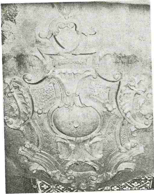
Vom einzigen noch erhaltenen Apostelzeichen wird ein Negativ für den Guß der fehlenden hergestellt.
