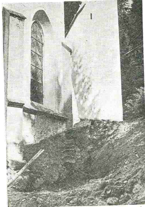
Die letzte Fundamentsanierung an der Südseite
