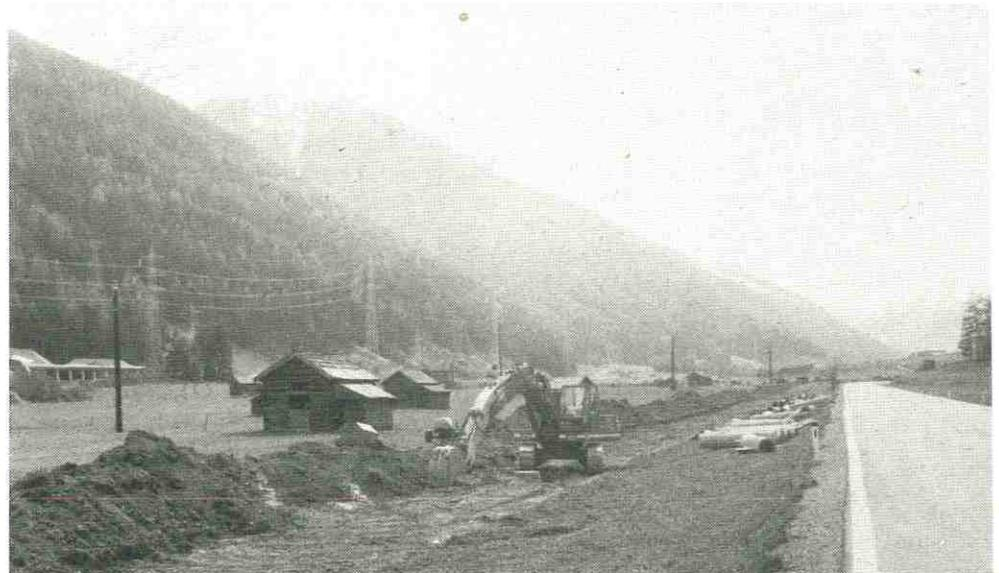
In den „Mösern“ zwischen Schnann und Pettneu wird gegenwärtig der Strang für die Sammelkläranlage Oberes Stanzertal verlegt. Das Vollbiologische Klärwerk wird in Flirsch errichtet.
