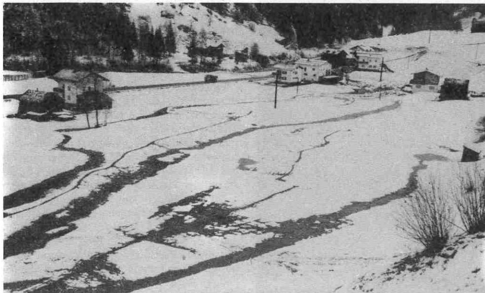
Dieses Bild zeigt eines der Probleme von See – der Beeinträchtigung des Talbodens durch Schmelzwässer, deren schadlose Ableitung heuer fertiggestellt wird.
