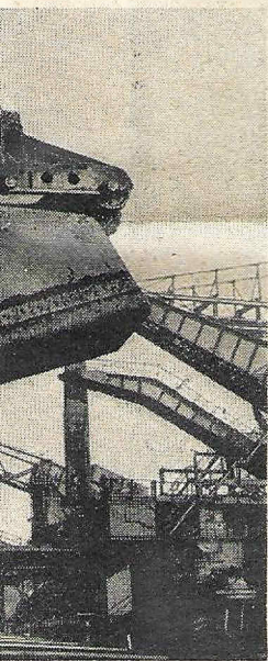
Der Transport von Erzen zu den Hüttenwerken erfolgt zu 85% auf dem Wasserweg. Die meisten Eisen- und Stahlwerke wurden an Wasserstraßen erbaut oder schufen sich nachträglich einen Zugang zum Binnenschiffahrtsnetz. Links: Die Pieranlagen eines Hüttenwerkes. Links unten: Für das Beladen der Ladung werden Spezialentladekräne eingesetzt, die aus unterhalb der Ladung über dem Greifer befindlichen Führerkabinen gesteuert werden.
