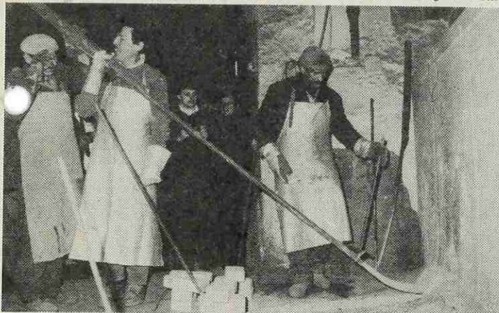
Die Vorbereitung zum eigentlichen Gußvorgang: das Reinigen der Gießkanäle und Schleusen, in denen das flüssige Bronzematerial in die Glockenformen fließt.
